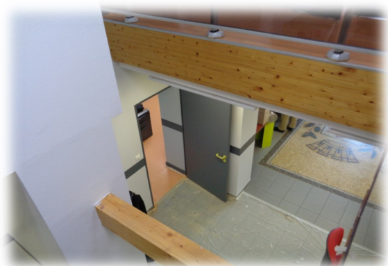
La Mairie pendant les travaux de peinture
